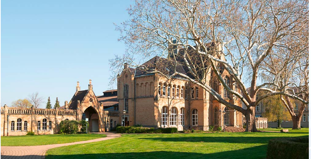
Historische Bausubstanz von 1866 – funktellisch auf dem neuesten Stand
